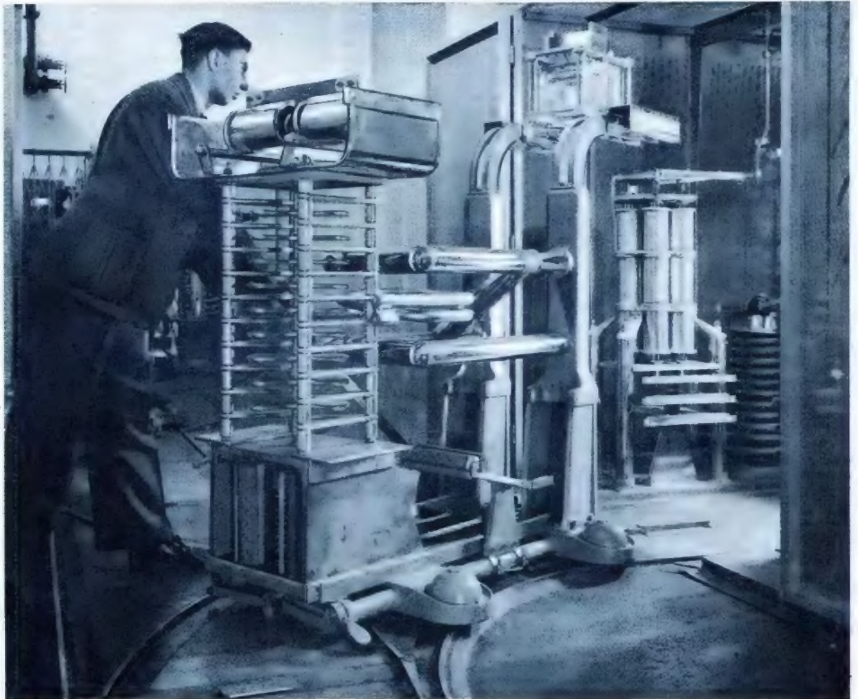
In die Endstufe eines der Kurzwellen-Großsender in Daventry wird ein austauschbares Abstimm-Aggregat eingefahren.
